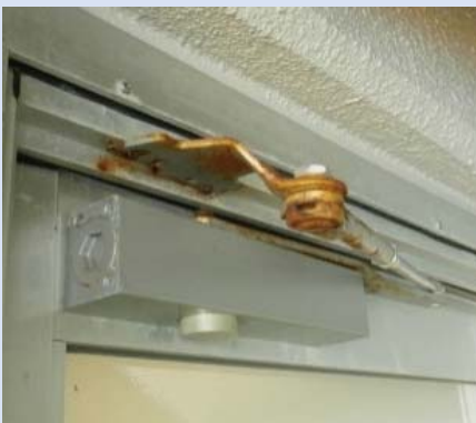
男子トイレ（ドアクローザ破損）
