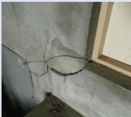
機械室(ドア建具周りの破損)
