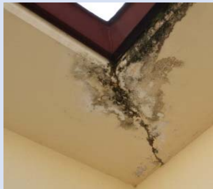
屋根(軒下部の亀裂)
