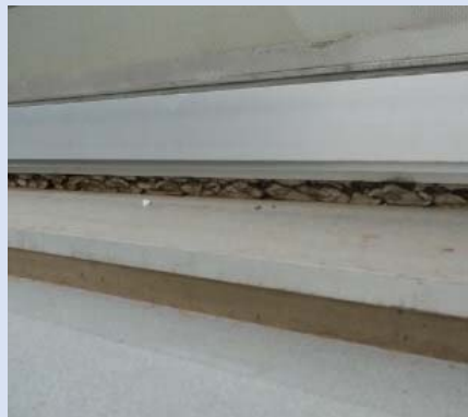
外部サッシ(シール硬化)
