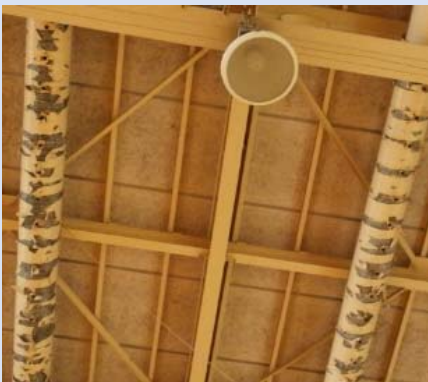
天井鉄骨(結露跡)
