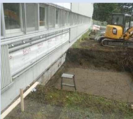
エレベーター設置箇所(基礎工事)
