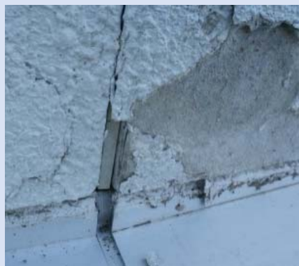
外壁(サイディング・シール破損)
