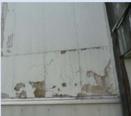
外壁(サイディング破損)
