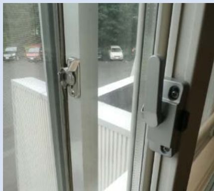
教室側断熱サッシ(カバー工法)
