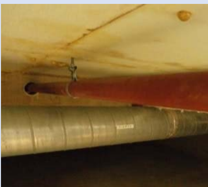
設備配管(蒸気配管劣化)
