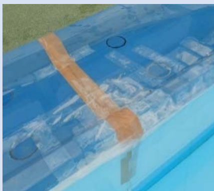
プール（貯水槽破損箇所）
