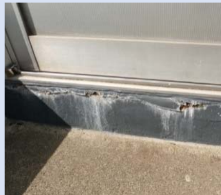
出入口（建具下部モルタル破損）
