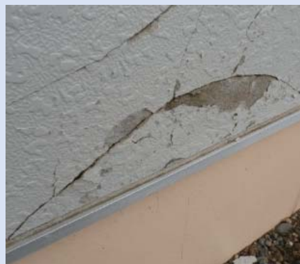
外壁(破損箇所)
