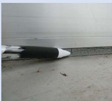
サッシ(外部シール硬化)
