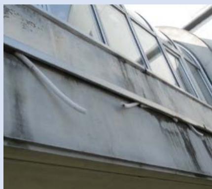
渡り廊下笠木(シーリング材破損)
