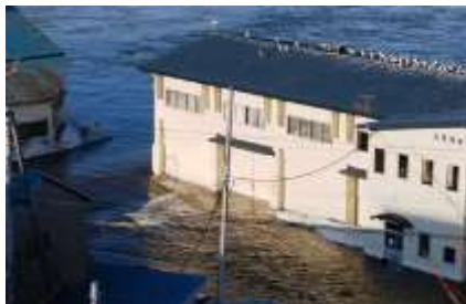
平成 23 年東北地方太平洋沖地震 (広尾町)
