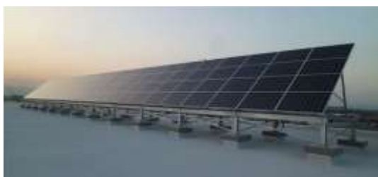
公共施設への太陽光パネルの設置
