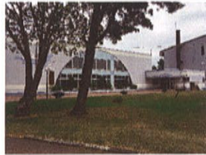
②町営水泳プール
