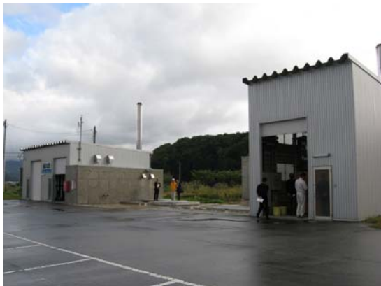
<ボイラ施設の外観>
