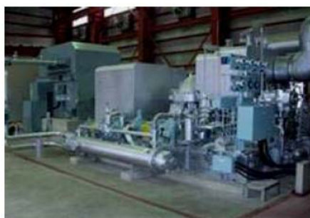
【発電用ボイラー】
