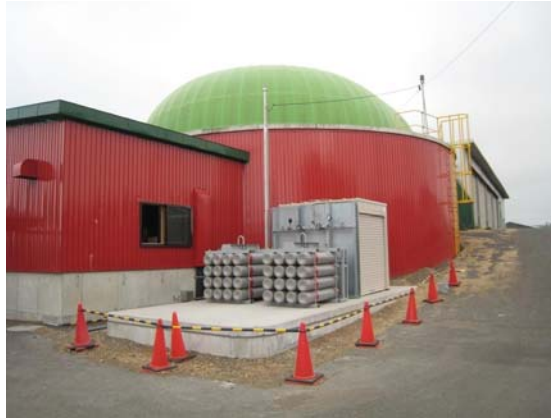
<バイオガスプラント>
