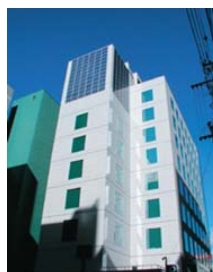
立体駐車場外壁
