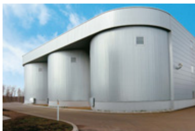
3基並ぶメタン発酵槽
