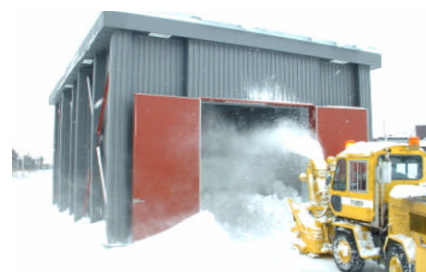
写真 4-7-2 美唄市老人福祉施設 ケアハウス「ハーモニー」の貯雪庫
