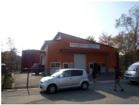
プラント管理棟
