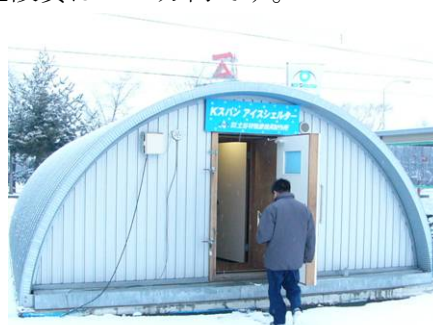
写真 4-7-6 農作物貯蔵施設
