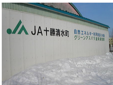
写真 4-7-1 JA 十勝清水の雪氷熱エネルギー利用施設
