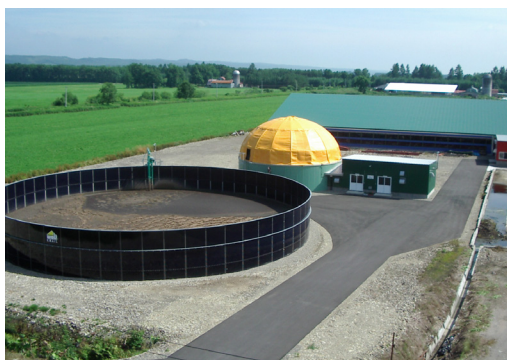
バイオガスプラント
