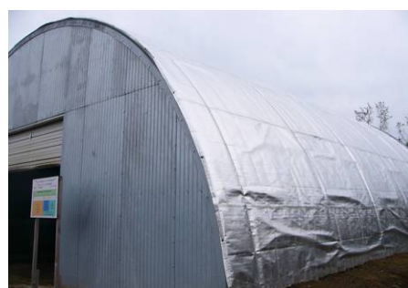
写真 4-7-5 断熱用ウレタンシートで覆っている
