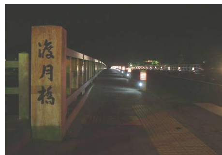
写真 4-10-3 渡月橋に設置された常設灯
