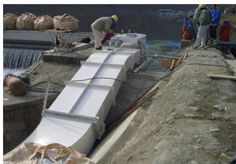
写真 4-10-2 発電設備設置の様子
