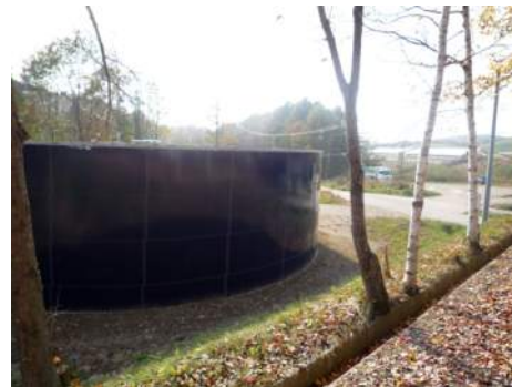
スラリータンク
