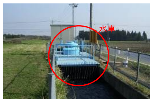
写真 4-10-5 水車設置後の様子
