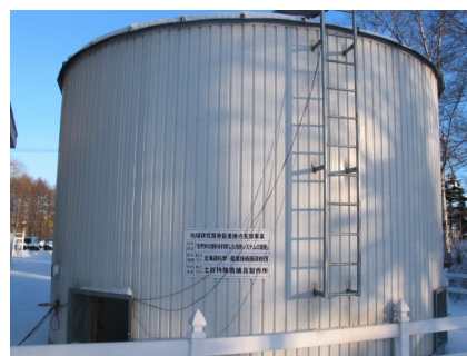
写真 4-7-7 室内冷房システム
