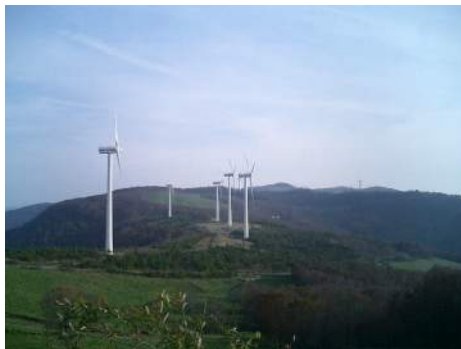
風力発電所全景
