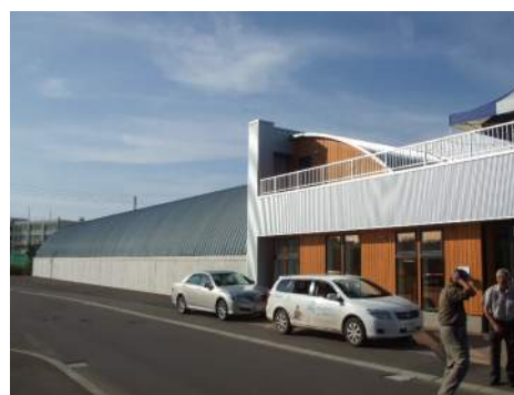
カーリング場はD型倉庫を断熱したもの
