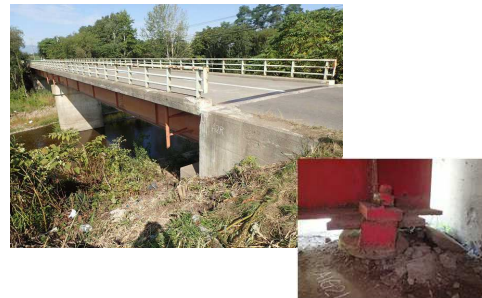
北伏古南7線橋(橋長78.18m) 昭和39年供用開始(55歳)
