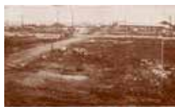
▲大火から2日後、瓦礫撤去後の中心市街地
