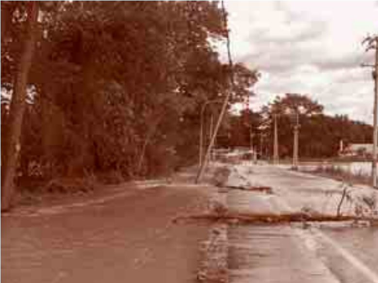
町道伏見・雄馬別線(10月3日開通になりました。)
