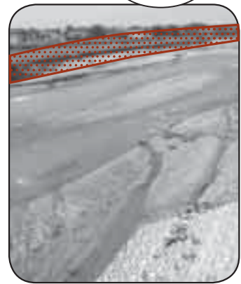
■ 箇所の復旧工事を実施中
