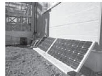
パネルを壁に立てかけて設置
