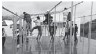
雨の中、夜遅くまで行ったカ フェデッキ設営作業。
