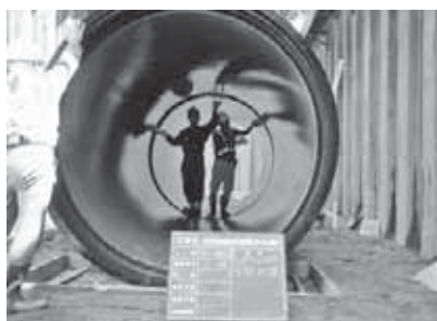
昨年設置した60トン型の貯水槽工事の様子
