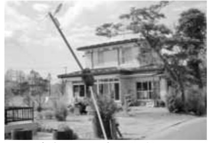
津波によって傾いた防犯灯
