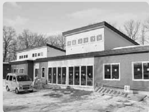
建築中の共生型施設(奥が「ふたば」)
