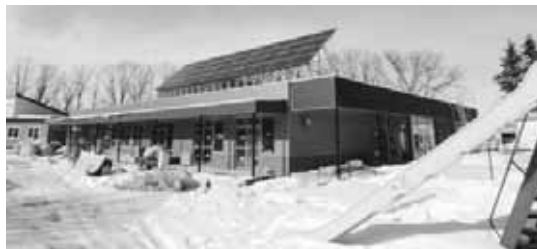
オープンに向け、工事が進む西子どもセンター
