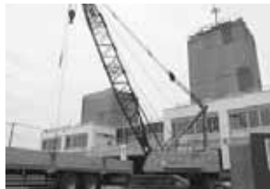
耐震改修中の消防署
