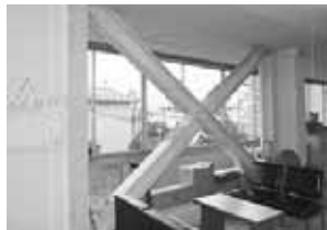
役場本庁舎内の補強鉄骨
