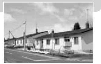
解体予定の旧職員住宅
