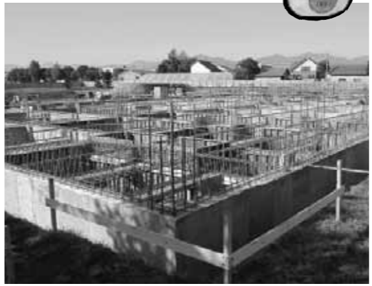
工事はまだ基礎部分です
