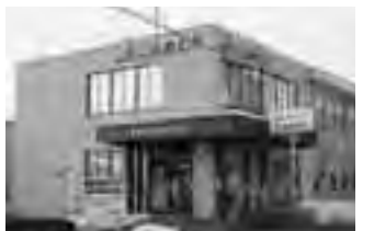
(建設予定地)東1条2丁目に30戸 平成22年2月完成予定
