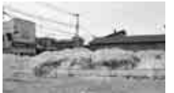
(建設予定地)東1条3丁目に6戸 平成21年10月完成予定
