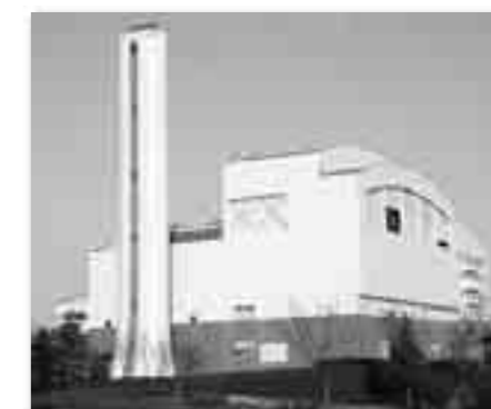
ごみの処理施設「くりりんセンター」
